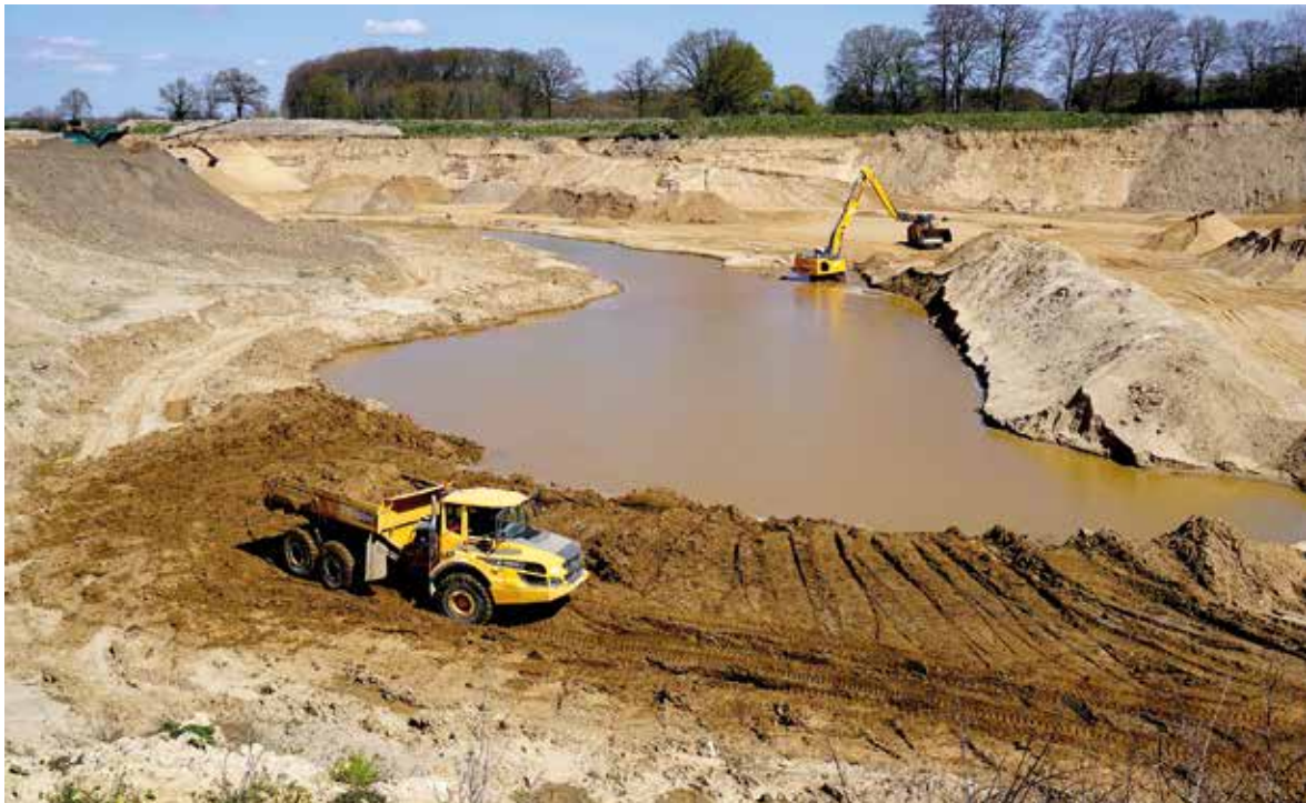
Ein Beispiel guter Praxis: Bei Oering im Kreis Segeberg in Schleswig-Holstein darf diese Kiessandgrube nass ausgekieset und danach unterhalb des Grundwasserspiegels mit unbelastetem Abraum und oberhalb des Grundwasserspiegels auch mit unbelastetem Fremdmaterial verfüllt werden. Eine landwirtschaftliche Nachnutzung ist dennoch auch in diesem Landkreis verboten – eine Renaturierung zum Wohle von Natur und Landschaft auch hier vorgeschrieben, Foto: BGR.
