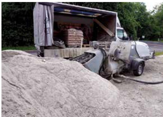
Estrichkies 0/8 mm, Zement und Wasser werden zumeist mit Hilfe einer Estrichpumpe vermischt und dann in Form von Fließestrich in den gewünschten Raum gepumpt, Foto: BGR.
