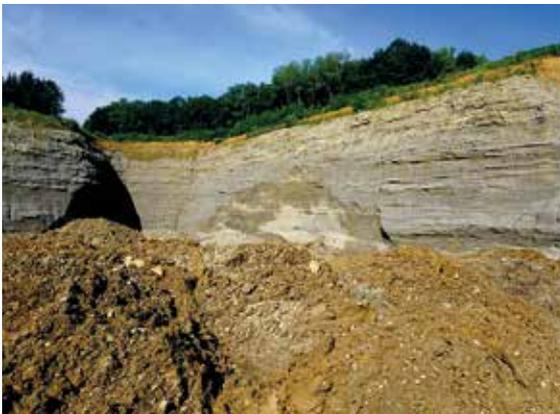
*Im KSV-KW Biberach-Rißegg werden die bis zu 45 m tiefen Grubenbereiche nach Auskiesung wieder vollständig mit unbelastetem Bodenaushub verfüllt und danach rekultiviert, Foto: BGR.*
