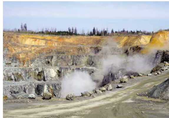
Gewinnungssprengung im Diabassteinbruch Huneberg der KEMNA BAU Andreae GmbH & Co. KG, Foto: BGR.
