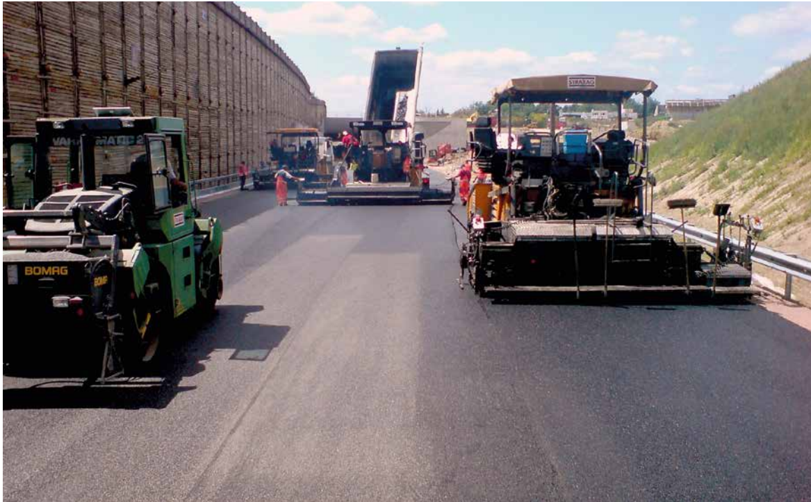
Asphaltfertiger der STRABAG SE beim Deckeneinbau von Walzasphalt am Mainzer Ring der A60 bei Mainz-Hechtsheim, Foto: Sonaz/Wikipedia.
