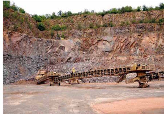
Der Quarzporphyr im Steinbruch Großsteinberg wird in einem semimobilen Backenbrecher vorgebrochen und gelangt dann über ein mehrere hundert Meter langes Förderband in die stationäre Aufbereitungsanlage, Foto: BGR.
