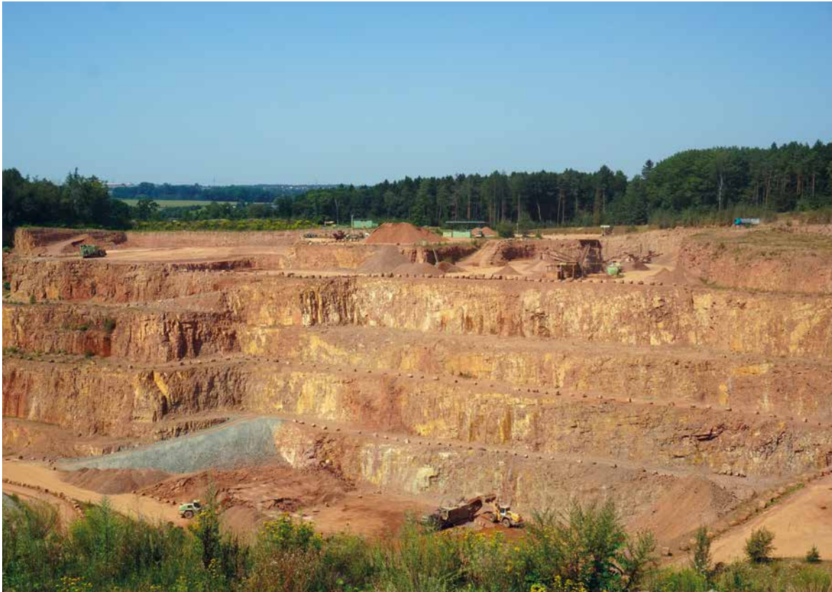
Blick in den Steinbruch Leukersdorf, wo durch die Geiger-Gruppe ein Quarzporphyrtuffstein abgebaut wird, Foto: BGR.
