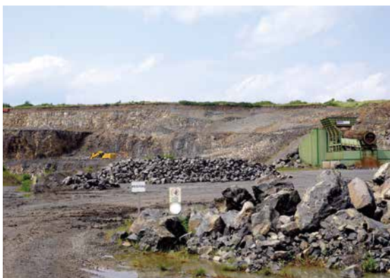
Mit einem Trommelsieb können im Steinbruch Fritzlar der Hermann Wegener Hessen GmbH & Co. KG Wasserbausteine der verschiedensten Größen hergestellt werden, Foto: BGR.
