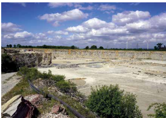
Kalksteingewinnung im weitestgehend ausgesteinten Steinbruch Rote Busch der Schotterwerk Westereiden GmbH & Co. KG in Anröchte. Auf der tiefsten Sohle findet bereits der Abbau von Naturwerksteinen statt, Foto: BGR.
