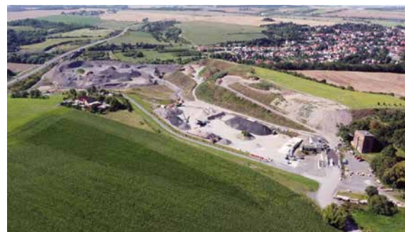
Luftbild der Abraumhalden der Freiesleben-Schächte I-III (links im Bild) sowie des Betriebsgeländes der Martin Wurzel HTS Bau GmbH (rechts im Bild), Foto: Martin Wurzel HTS Bau GmbH (mit frdl. Genehmigung).
