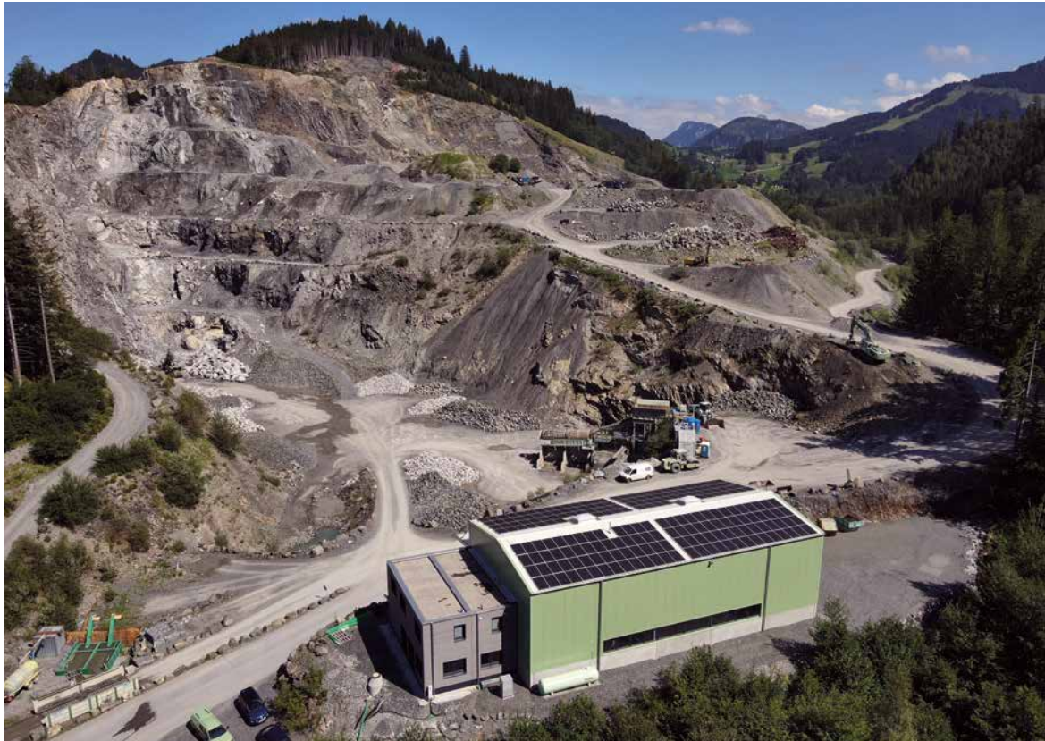
Der Steinbruch Wertach der Geiger Gruppe aus Oberstdorf ist der einzige verbliebene Steinbruch im Allgäu, Foto: Geiger Baustoffe- und Recycling GmbH & Co. KG (mit frdl. Genehmigung).
