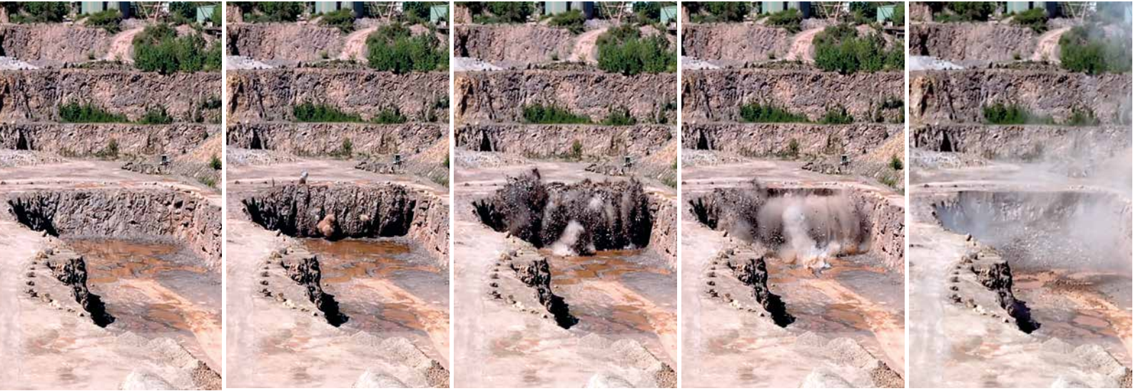
Durchführung einer Sprengung, Zeitraum: ca. 15 Sekunden, Fotos: Marius Hübner, Mitteldeutsche Baustoffe GmbH (mit frdl. Genehmigung).
