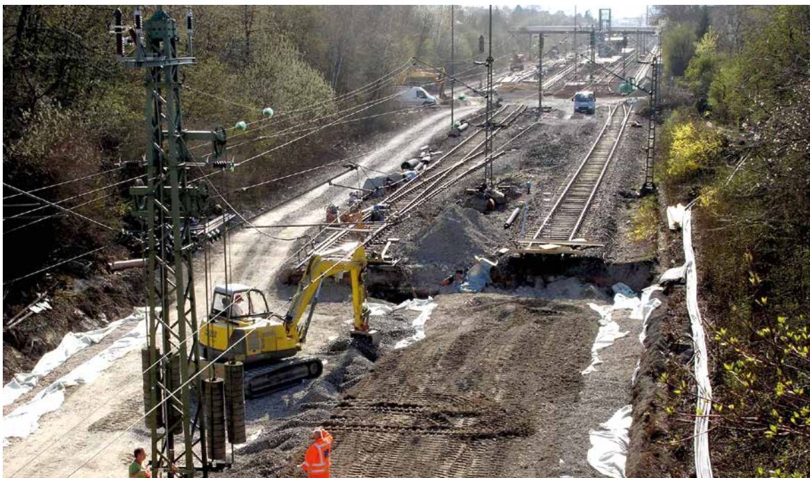
Gleisbaumaßnahmen am Bahnhof Korntal im baden-württembergischen Landkreis Ludwigsburg im Frühjahr 2010, Foto: Harke/Wikipedia.
