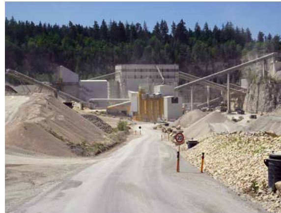
Der Steinbruch mit angeschlossenem Schotterwerk Wiesenhofen der Max Bögl Stiftung & Co. KG ist vornehmlich auf die Versorgung der unternehmenseigenen Betonfertigteilwerke mit hochfesten Edelsplitten ausgelegt, Foto: BGR.
