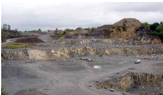
Im Steinbruch Strohn der Ernst Scherer Baustoffe GmbH & Co. KG wird auf mehreren Sohlen Basalt unterhalb von Lavaschlacken abgebaut, Foto: BGR.
