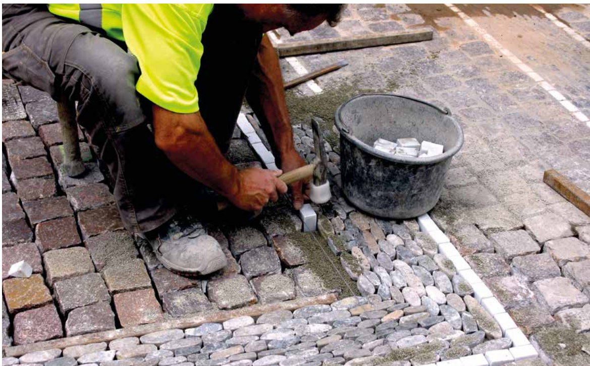
Pflasterarbeiten am Bertoldsbrunnen in Freiburg, wo normgemäß Edelbrechsande 0/8 mm als Pflasterbettungsmaterial und 0/5 mm als Pflasterfugenmaterial zum Einsatz kamen, Foto: Andreas Schwarzkopf/Wikipedia.
