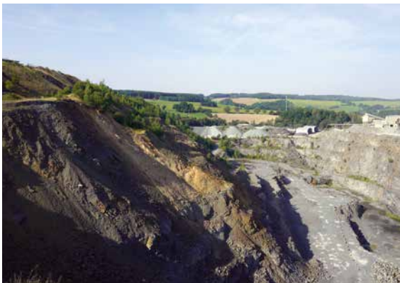
Blick in die Abbaustelle Hohe Hut mit großer Rutenschungsfäche links im Bild, Foto: BGR.
