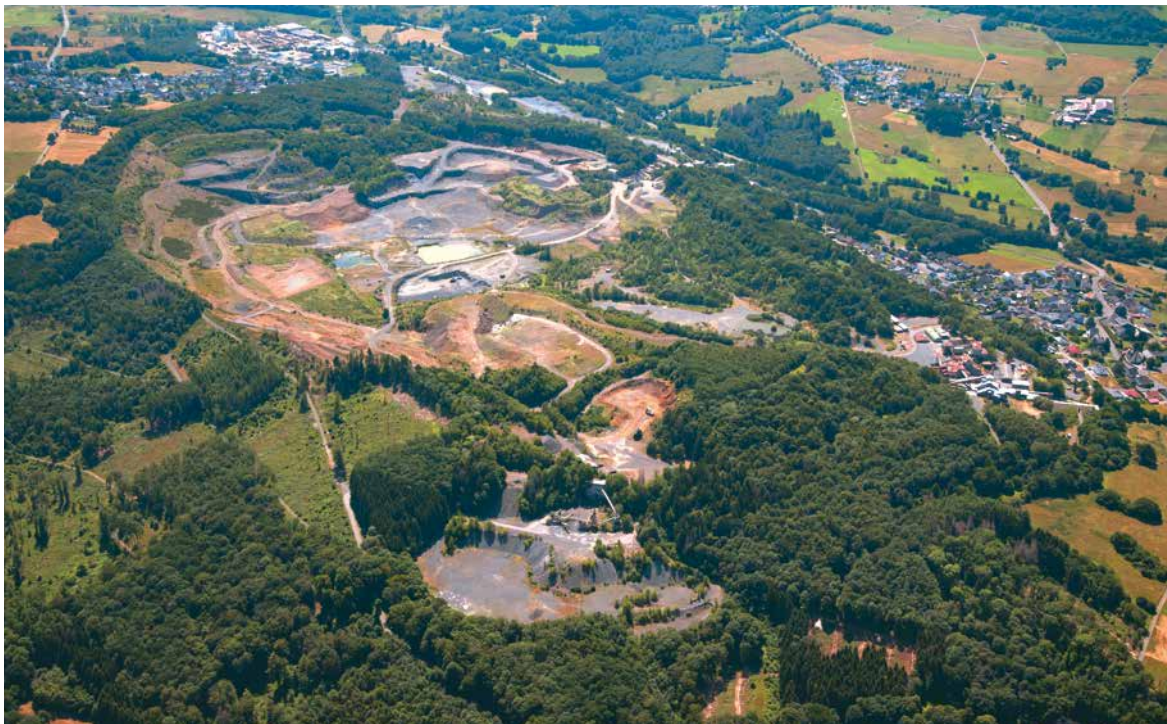
Luftbild des Abbaugeländes der Basalt AG, rechts der Bereich des Stöffel-Parks, Foto: Bergisch-Westerwälder Hartsteinwerke (mit frdl. Genehmigung).
