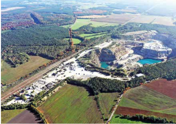
Luftaufnahme des Granitsteinbruchs und Werks Schwarzkollm mit gut sichtbarer Zugverladungsmöglichkeit im linken Bildvordergrund, Foto: Natursteinwerke Weiland GmbH (mit frdl. Genehmigung).
