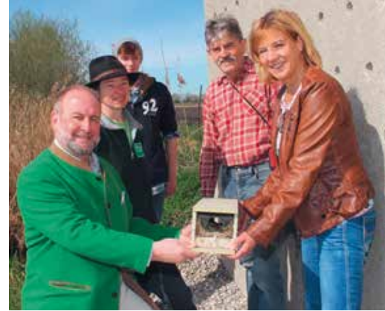
Bau eines Uferschwalbenhauses mit 120 Nisteinrichtungen.
