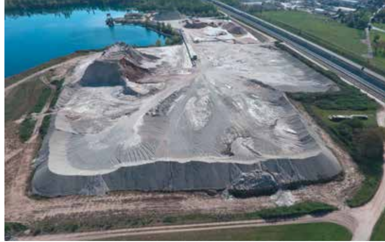
Lagerfläche für das Tunnelausbruchmaterial: Durch eine gezielte Aufbereitung konnten rund 700.000 m 3 Deponievolumen eingespart werden.
