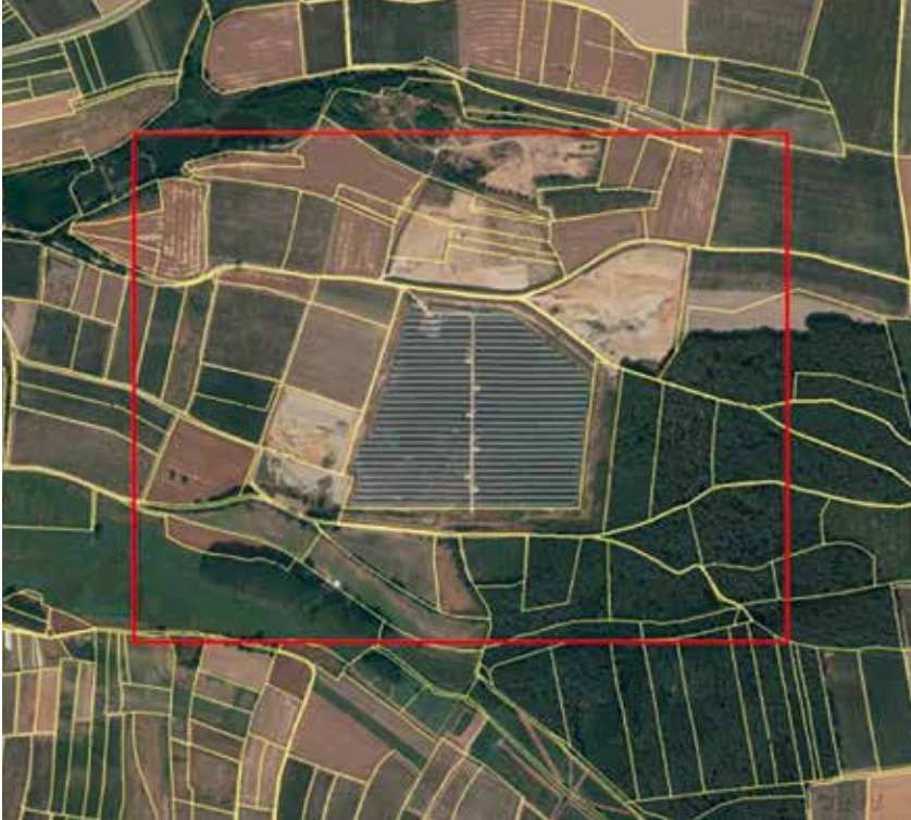
Die ehemaligen Abbauflächen wurden zu einer der ersten Freiflächen-Photovoltaik-Anlagen in Bayern umgewidmet und realisiert.
