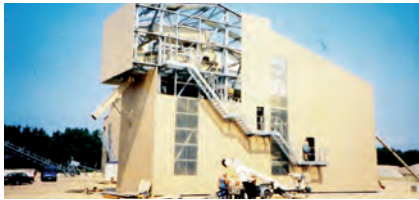
1995 Aufbau der Sandklassieranlage für die Transportbetonindustrie. Fotos: Albrecht Schmieder
