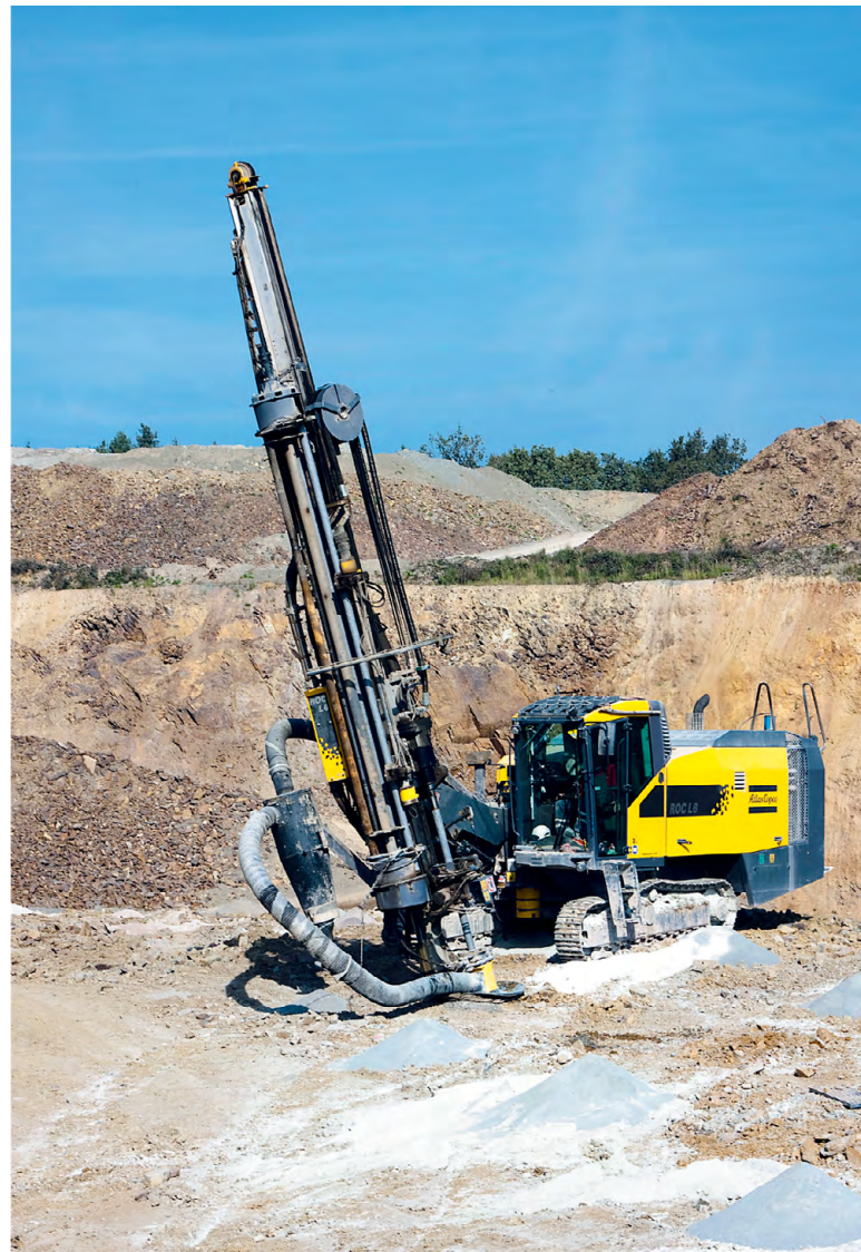
16. Zuerst wird das Sprengloch gebohrt...
