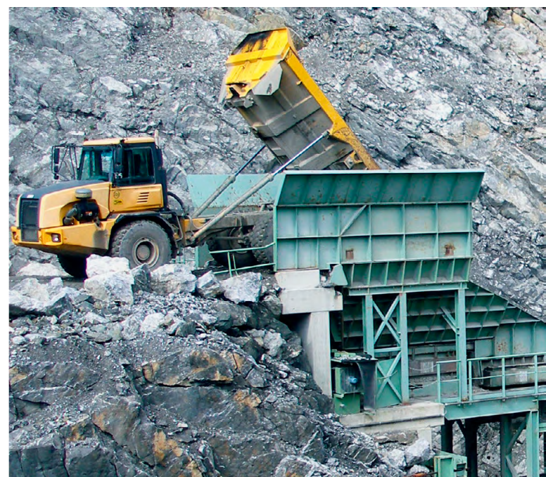
19. Die Ladung wird in den Brecher gekippt.
