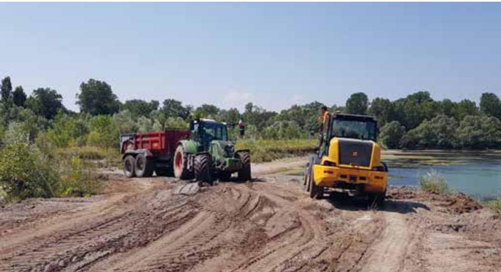
**Anschüttung höherer Geländezone auf dem Inselfundament mit externem Boden.**
