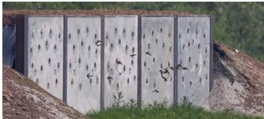
„Plattenbau“ der anderen Art: Künstliche Steilwand aus Beton mit einer Vielzahl von Bohrlöchern als Nistplätze für Uferschwalben.
