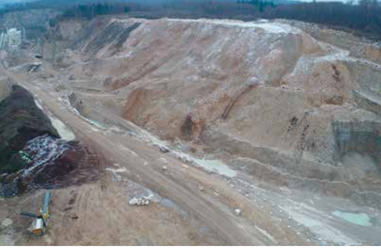
Durch eine neue Bodenwaschanlage werden vom Haldenvolumen von ca. 3,5 Mio. m 3 ca. 80 % Wertkorn gewonnen.
