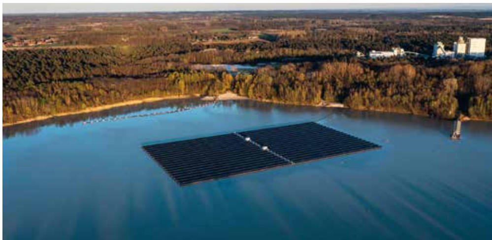
Die 3,1 MWp starke Floating-PV-Anlage in Haltern am See ist der Startpunkt des Transformationskonzepts der Quarzwerke.
