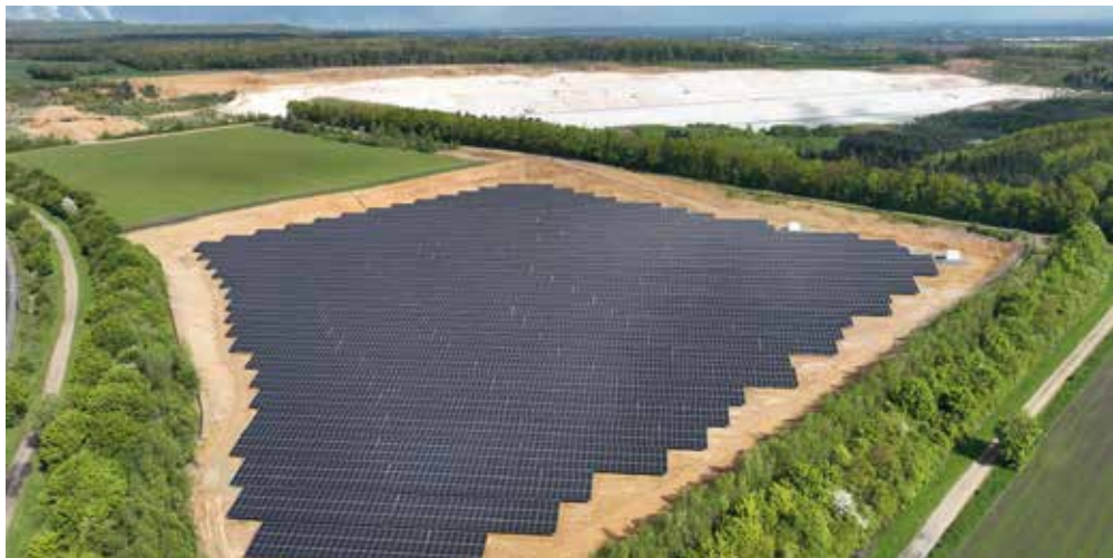
Die Freiland-PV-Anlage in Frechen ist mit 6,5 MWp derzeit die größte PV-Anlage der Quarzwerke und ging im Mai 2024 ans Netz.
