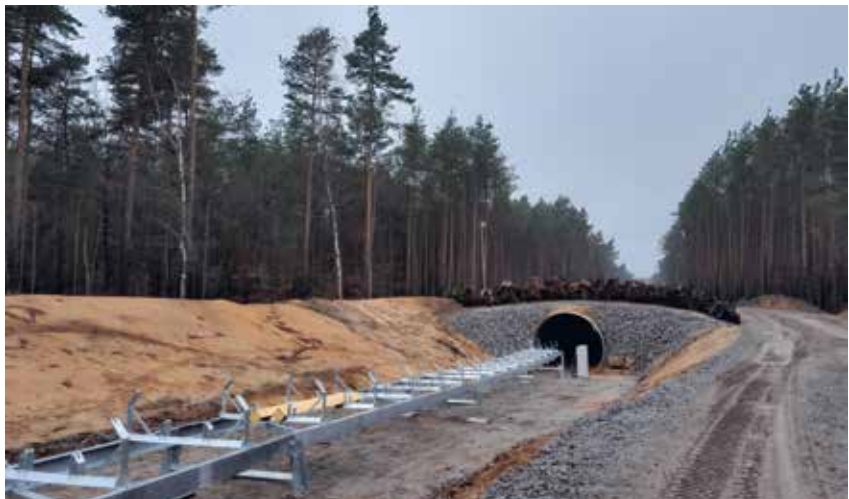
Mehrere Tunnel für Straßenquerungen sowie für den Wildwechsel wurden errichtet; hier: Montage der Bandgestelle.
