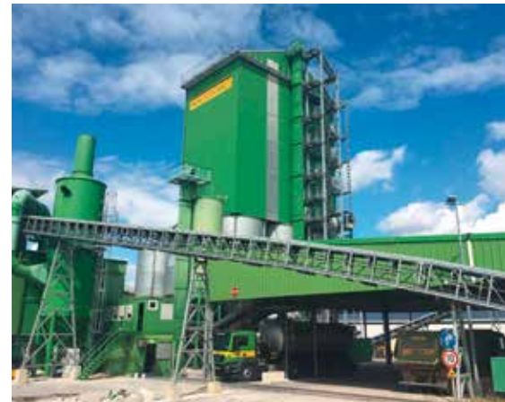
Quarzsandaufbereitungsanlage zur Veredlung der Quarzsande und Kiese mittels Trocknung, Siebung und Mischung.
