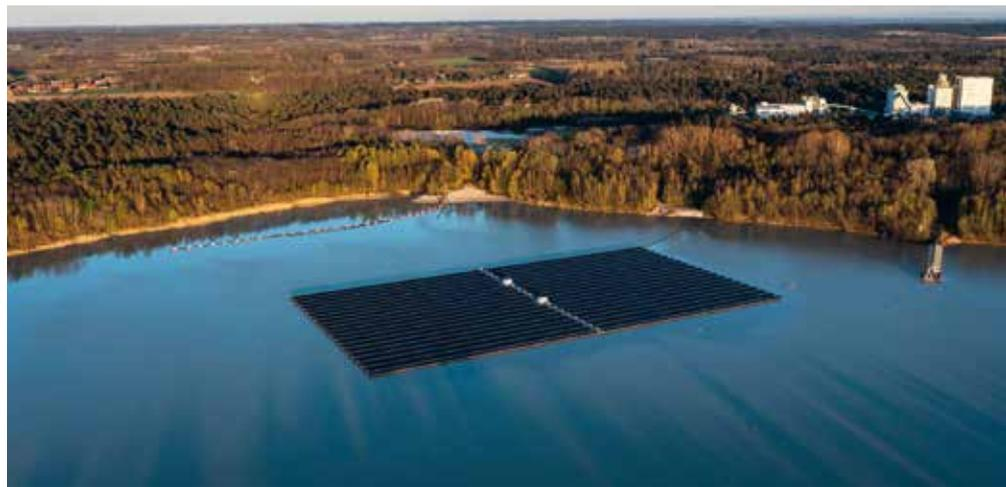
Die 3,1 MWp starke Floating-PV-Anlage in Haltern am See ist der Startpunkt des Transformationskonzepts der Quarzwerke.
