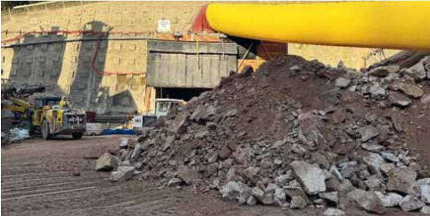
**1 Mio. t Tunnelausbruchmaterial werden unter dem Motto „Granit zu Granit“ zunächst zwischengelagert und dann zu einem qualifizierten Baustoff aufbereitet.**
