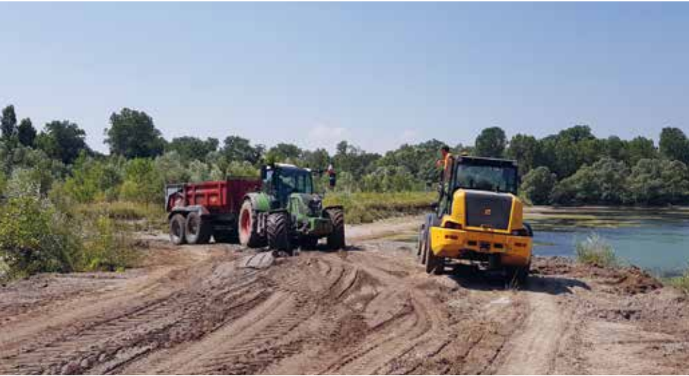
Anschüttung höherer Geländezonen auf dem Inselfundament mit externem Boden.
