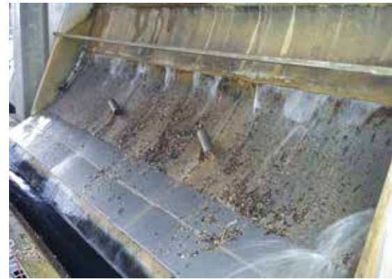
Das Wasser mit groben Bestandteilen wird über Bogensiebe geführt, dort gereinigt und ist dann wieder verwendbar.
