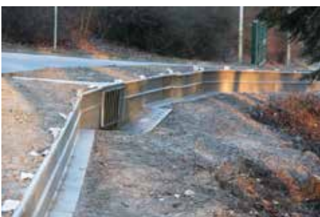
585 Erdkröten haben 2012 den neuen Amphibientunnel genutzt, um zu ihrem Laichgewässer im renaturierten Tagebaubereich zu kommen.
