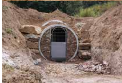
Bau einer Fledermauswinterhöhle mit einem Innendurchmesser von 2,20 Meter: Im Inneren sind in einem mäandrierenden Muster spezielle Hohlblock- und Kalksandsteinmauern angelegt, die sowohl spalten- als auch höhlenbewohnenden Fledermäusen Unterschlupf bieten.
