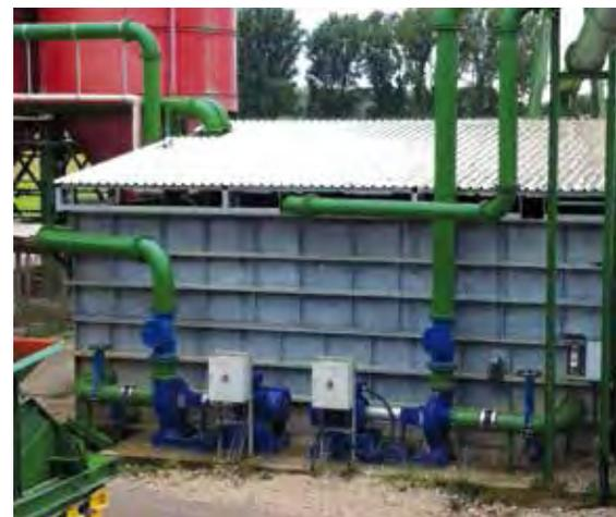
**Zwischenspeicher mit Pumpen für die Sandaufbereitung und Siebmaschinen.**
