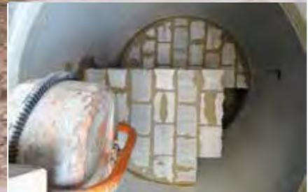
Bau einer Fledermauswinterhöhle mit einem Innendurchmesser von 2,20 Meter: Im Inneren sind in einem mäandrierenden Muster spezielle Hohlblock- und Kalksandsteinmauern angelegt, die sowohl spalten- als auch höhlenbewohnenden Fledermäusen Unterschlupf bieten.
