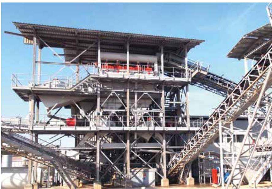
**HALDENAUFBEREITUNG IN ITALIEN:** Dort ist eine Alljig-Feinkornsetzmaschine von Allmineral im Einsatz.
