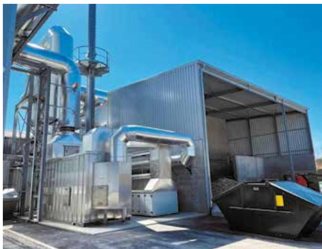
**STARTPUNKT:** Im Außenbunker landet die Biomasse zuerst. Für die Hochtemperaturanwendung im Bereich der indirekten Befuerung sind komplexe Heißgas-Wärmetauscher notwendig.
