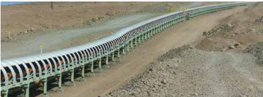
17 km langer Haubentunnel in Peru aus einer Kombination von schmalen AFlex-Bügeln und einseitig offenen Sichthauben
