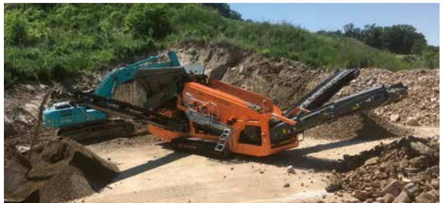
Separieren von Bauschutt mit der mobilen Grobsiebanlage RSS514
