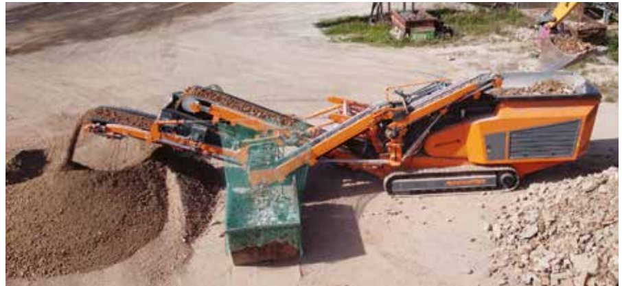
Bauschuttaufbereitung mit dem mobilen Prallbrecher R1000S inkl. Siebssystem und Windsichter
