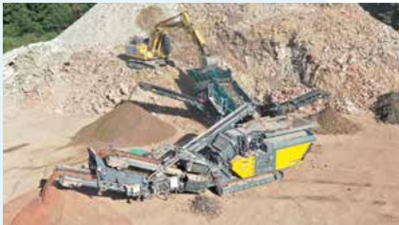
Brechen und Sieben im Bauschuttrecycling
