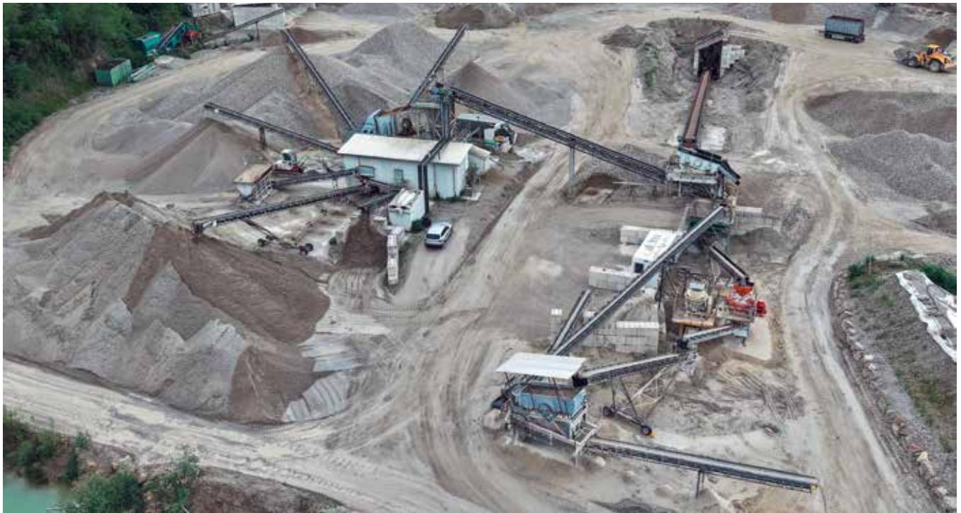
schuss werden bereits seit 2010 durch einen 80-t/h-Kegelbrecher unmittelbar neben der Kieswaschanlage zu Splitten und Brechsanden vornehmlich für die Asphaltherstellung verarbeitet.
