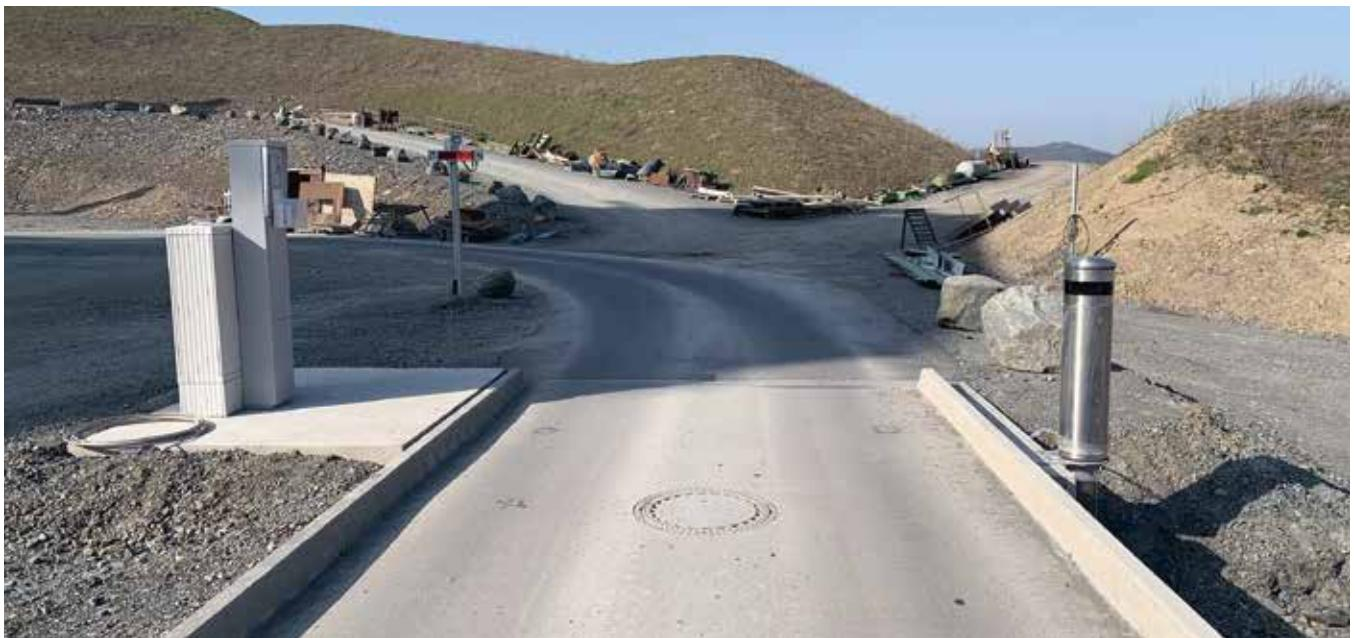
**STEUERUNGSGRUNDLAGE:** Mit einer Kennzeichenerfassung – im Stahlpfahl rechtsseitig – schafft der Betreiber hier an einer Waage die Voraussetzung einer kontrollierten Betriebssicherheit. Fotos: Uniserve
