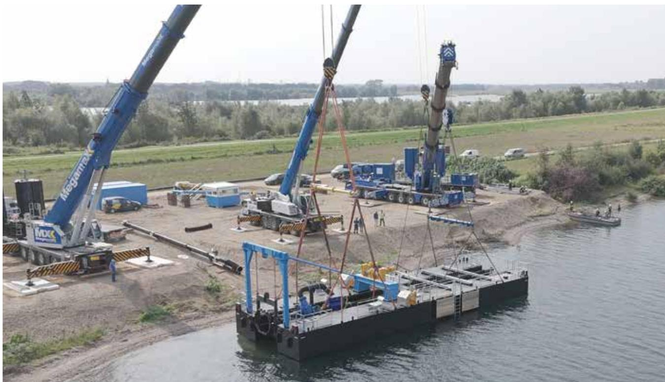
**ZUNÄCHST WURDE DAS CHASSIS** mit zwei Autokränen ins Wasser gehoben. Dann folgten Aufbau der beiden Arbeits- und Technikcontainer, der Steuerkabine sowie Treppen und weitere Aufbauten. Fotos: Hülskens
