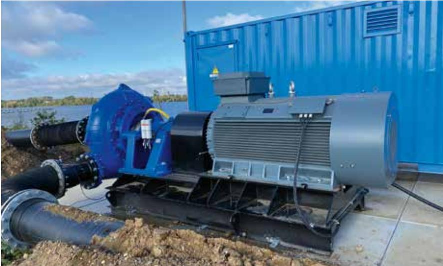
**FÜR EINE EFFIZIENTE FÖRDERLEISTUNG** sind zwei ergänzende Boosterpumpen an Land in die gesamte digitale Prozesssteuerung integriert.
