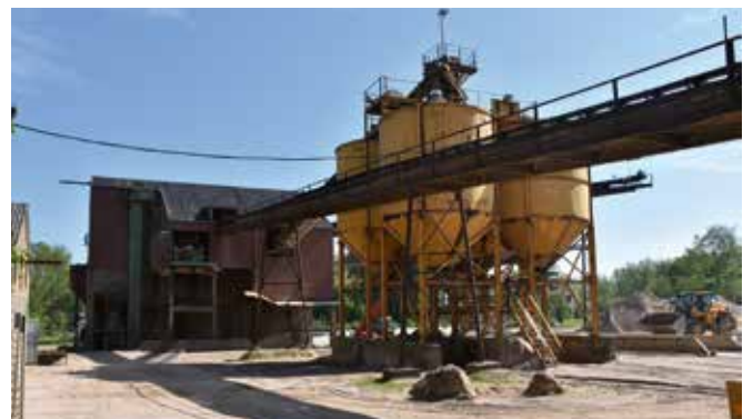
BEWÄHRT UND EFFIZIENT: Neben der Aufbereitung sorgt eine Siloanlage für die unmittelbare Verladung der Produkte.
