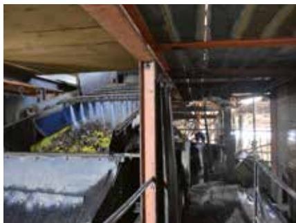
EINE NASSAUFBEREITUNG über ein Vier-Deck-Sieb trennt die Komponenten in die nötigen Fraktionen.
