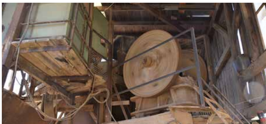
BEWÄHRTER OLDIE: Der mächtige Kleemann-Backenbrecher erfüllt noch nach über 65 Jahren seinen Dienst im Werk Kalletal.
