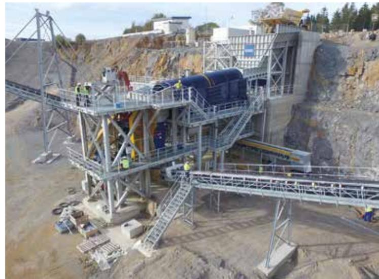
**MIT DER SCHWERKRAFT:** Der zentrale Turm besteht aus dem Trommelsieb und dem mächtigen Backenbrecher von Hazemag. Foto: Spenner
