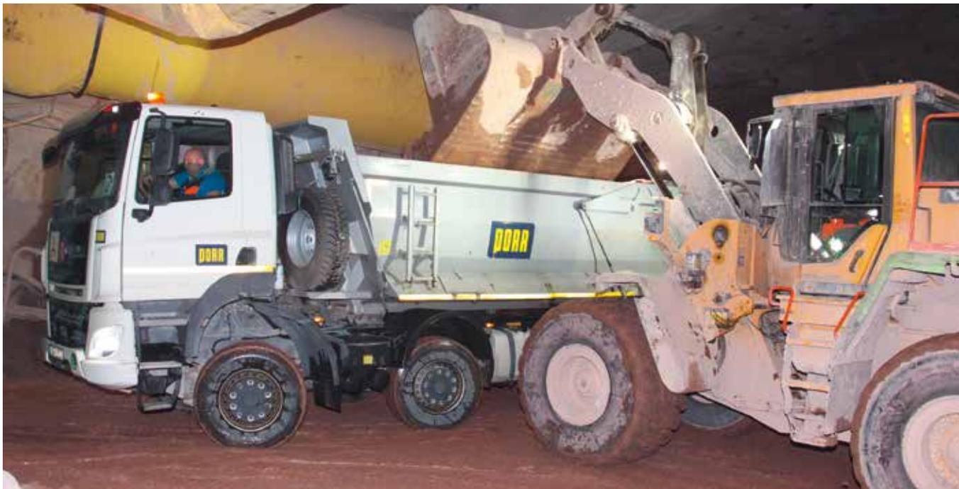
**VERLADUNG IM TUNNEL:** Dort wird das Schuttermaterial verladen und abtransportiert. Fotos: Tschann
