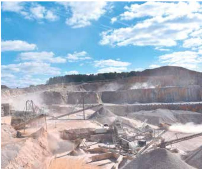
**GEZIELT PLATZIERT:** Die komplette Anlage wurde – auch zur Energieeinsparung – auf den Boden einer tiefen Sohle positioniert.
