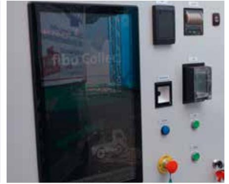
**DETAILS IM BLICK:** die BTS-Steuerungseinheit und das Bedienterminal.
