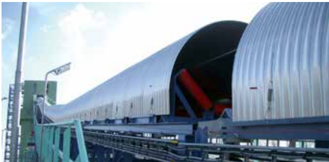
IM EINSATZ VOR ORT: die beidseitig zu öffnende Loop-Haube im Einsatz.
