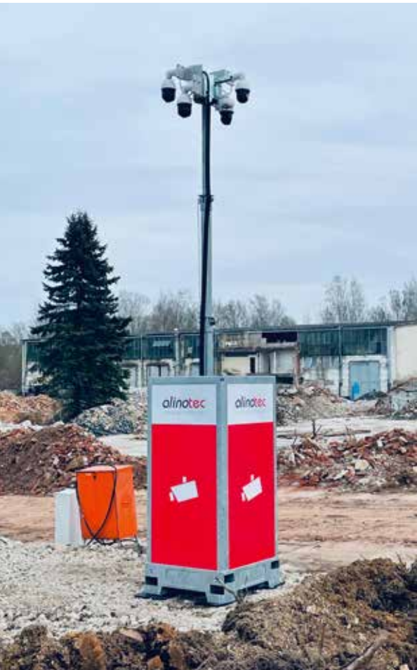
BAUDOKUMENTATION: Kopplung mit einem Video-Tower. Fotos: Alinotec
