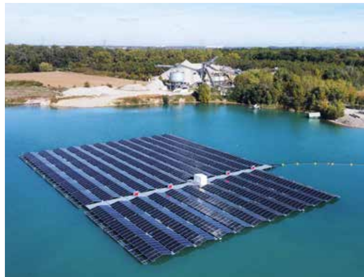
HESSENS NR. 1: FPV-Anlage in Crumstadt.
