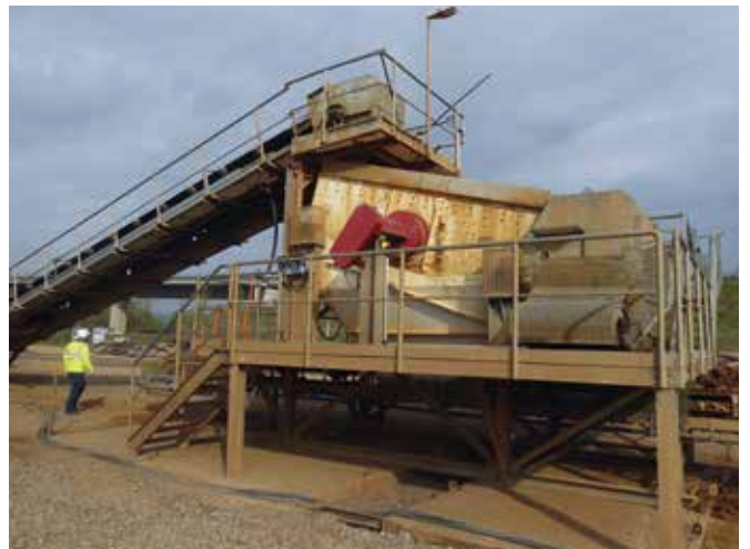
ERSTER SCHRITT IM KIESWERK: Geneigte Vorsiebe zur Steinabtrennung sind häufig einfache Kreisschwingmaschinen mit einer Welle. Foto: bwi
