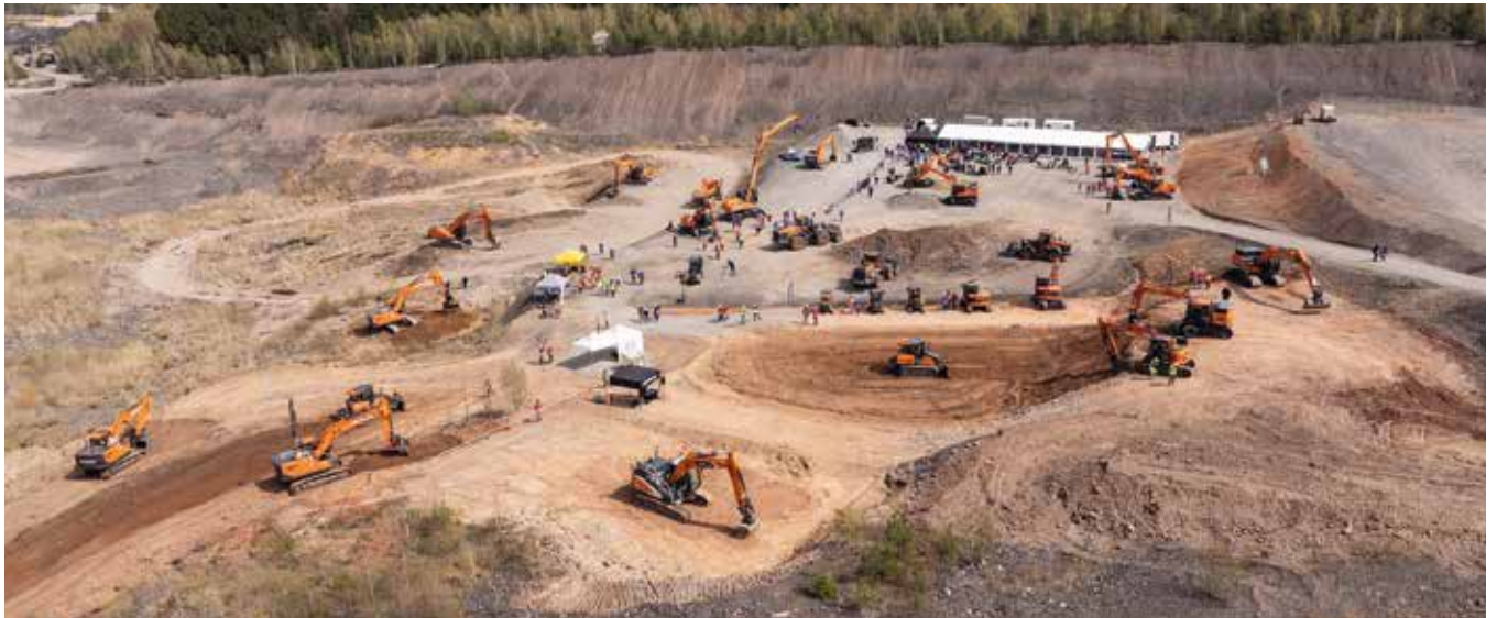
IM STEINBRUCH HÁJE bei Prag fanden die Develon Demo Days 2026 statt. Foto: Develon
