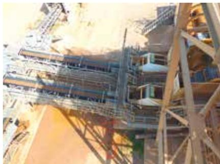
**WICHTIGER ZWISCHENSCHRITT:** Aus der Schöpfradanlage wird kontinuierlich entwässertes Kiesmaterial in die folgende Aufbereitung geleitet.
