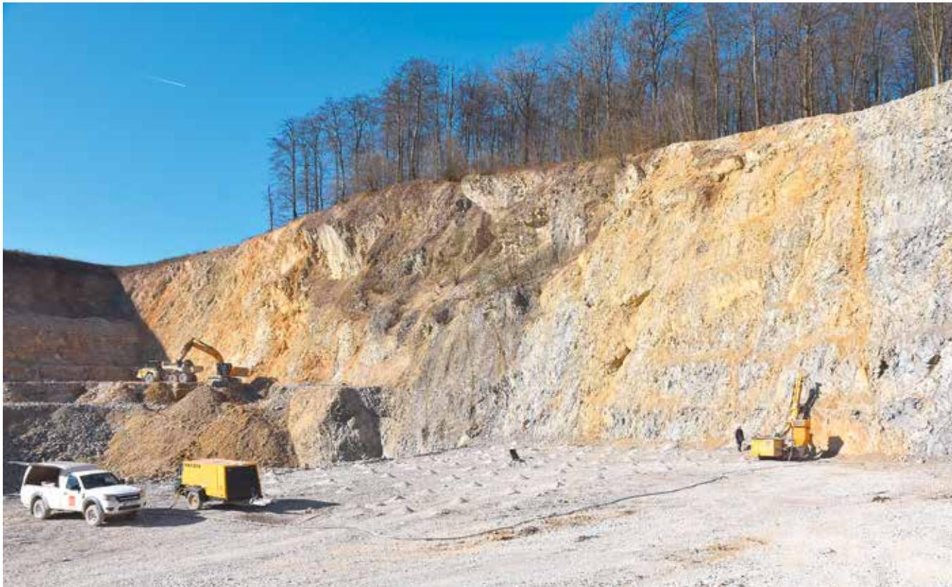
**GEORDNETES FELD:** Auf den ebenen Flächen wird mit dem kleinen Bohrgerät und separatem Kompressor gearbeitet. Eng gesetzte 120 Bohrlöcher ergeben ca. 4200 m<sup>3</sup> gelösten Fels. Fotos: Wistinghausen
