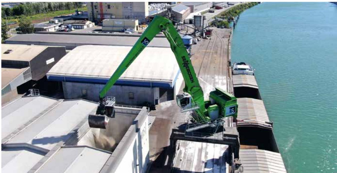
**DANK VERSCHIEBBAREM HALLENDACH** sind die drei Lagerkammern der Umschlaghalle von oben per Bagger beladbar. Foto: Danubia Speicherei
