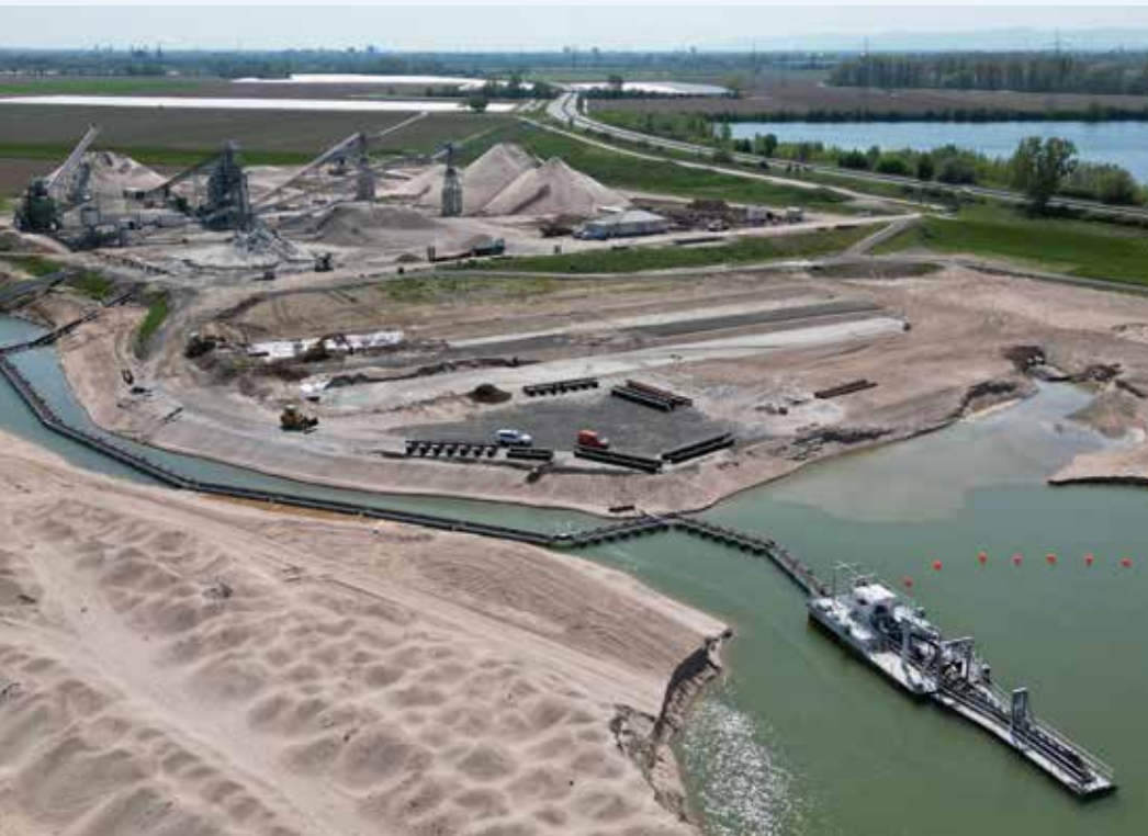
ALLES GANZ NEU: Im Hintergrund das Kieswerk, vorn das Gewinnungsgerät auf dem frisch entstandenen See. Fotos: Dredgers & Pumps
