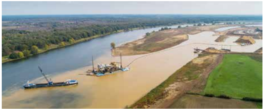
HOCHWASSERRINNE zur Entlastung im Überflutungsfall, exakt ausgeformt per Schneidradaugbagger. Entnommener Sand und Kies wurde von der schwimmenden Aufbereitung direkt klassiert und auf Schiffe verladen.
