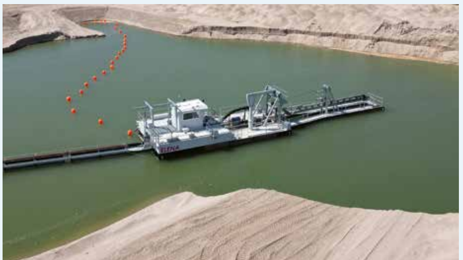
ELENA BEI DER ARBEIT: Geliefert wurde der/die Saugbagger/in vom Emmericher Spezialisten Dredgers & Pumps.
