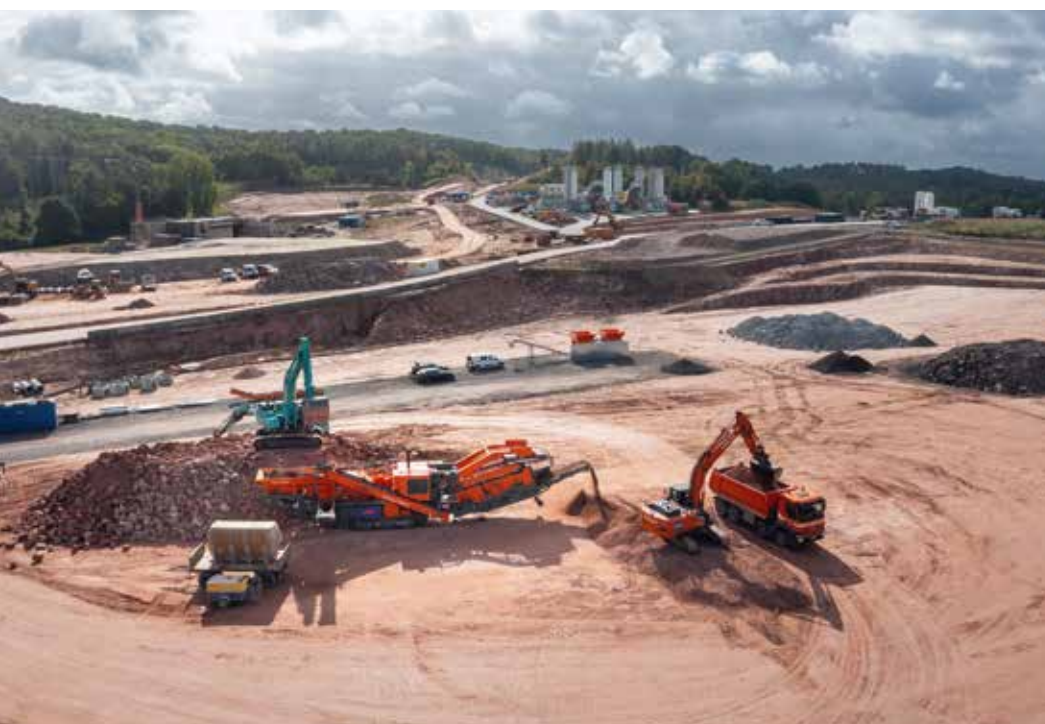
DIE BAUSTELLE AM HOLSTEIN-TUNNEL ist nicht nur wegen ihrer Größe mehr als beeindruckend.
