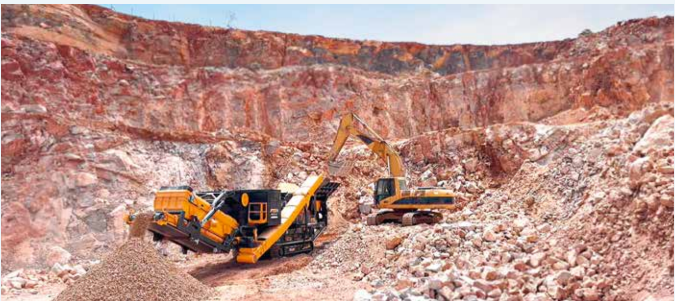
EFFIZIENTE MATERIALFLÜSSE: Mobile Förder- und Aufbereitungstechnik optimiert Prozesse und reduziert interne Transportwege auf der Baustelle. Foto: Lutze Process Germany GmbH
