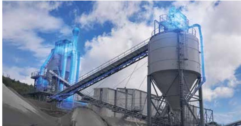
**IM SCHOTTERWERK** sorgt Scheuch-Entstaubungstechnologie für eine effiziente Reduzierung von Staubemissionen. Foto: Scheuch
