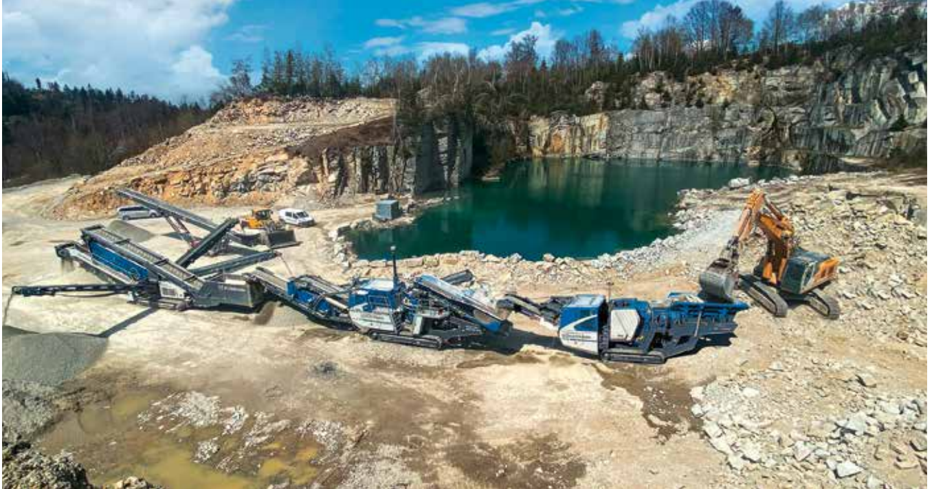
GEMISCHT: Aufbereitung im Steinbruch mit unterschiedlichen Antrieben bei Kleemann: Der Backenbrecher MC110EVO2 und der Kegelbrecher MC090EVO2 arbeiten mit Dieseldirektantrieb, das Klassiersieb mit dieselhydraulischem Konzept. Foto: Kleemann
