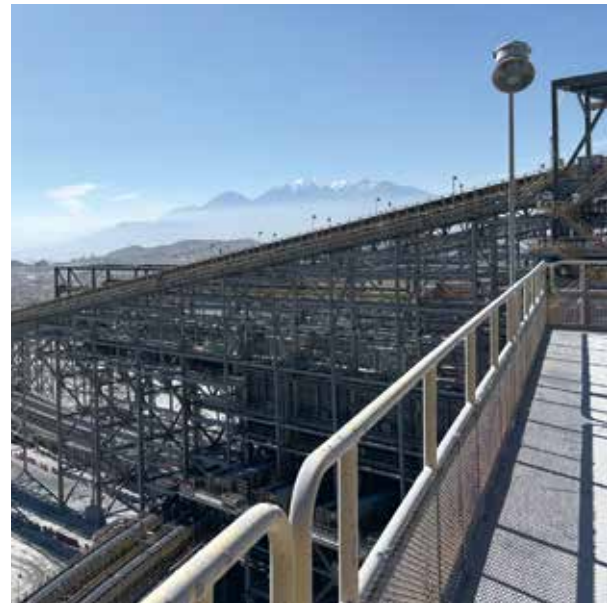
BESONDERS RENTABEL ist eine Umrüstung bei Großanlagen mit hohem Transportvolumen.
