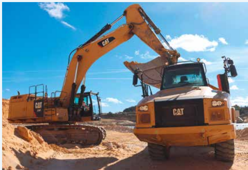
STARK VERFESTIGTER SANDSTEIN muss im Trockenabbau gelöst und verladen werden.
