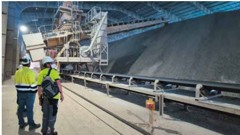
BEGUTACHTET: Diese Bandanlage steht kurz vor ihrer nächsten Inspektion.
