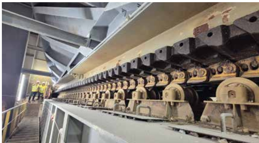
INSPEKTION EINES PLATTENBANDES: Unterhalb eines großen Aufnahmebunkers steht die Inspektion durch MCI an.
