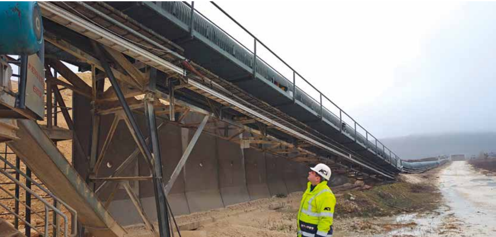
VOR ORT: Baustellenbesuche und Serviceeinsätze wie an dieser Verbindungsbandanlage gehören zum umfangreichen MCI-Portfolio. Fotos: MCI
