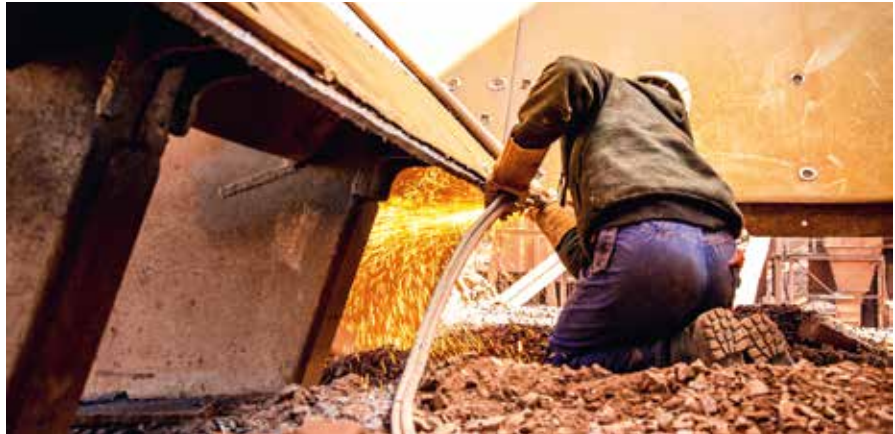
SCHWEISSARBEITEN am Brecher gehören zum Service dazu.
