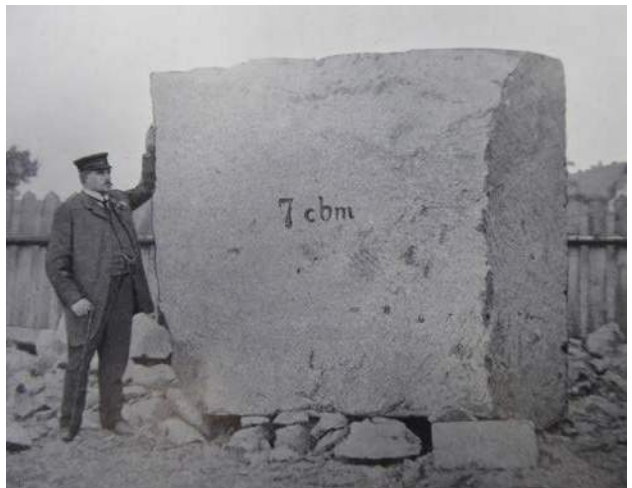
Abbildung 2: Suevit-Block von 7 Kubikmeter Größe für den Postneubau (in der Grottenau) in Augsburg (Foto: aus STRAUB 1907).
