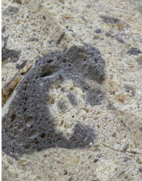
Abbildung 5: Auf der Fassade des Eisenbahn-Bundesamts: Fläde in Form eines Schlangenkopfs (Foto: Klaus Poschlod).
