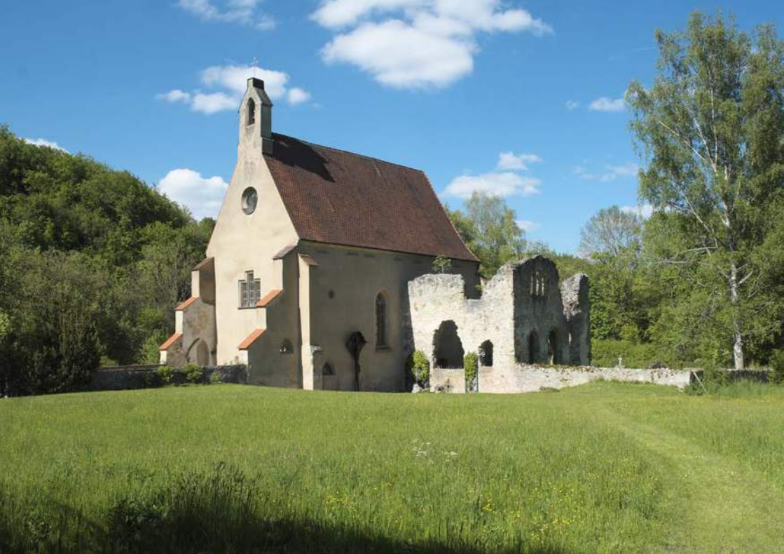
Abbildung 1: Klosterruine Christgarten; Erstes Zeugnis für den Einsatz von Suevit als Baustein im Mittelalter (Foto: Memorino).
