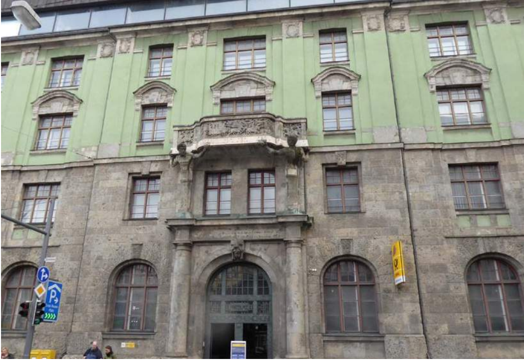
Abbildung 3: Post in der Grottenau in Augsburg, EG und 1. OG aus Suevit, der Sockel besteht aus Nagelfluh, der nördlich von Augsburg gewonnen wurde (Foto: Klaus Poschlod).
