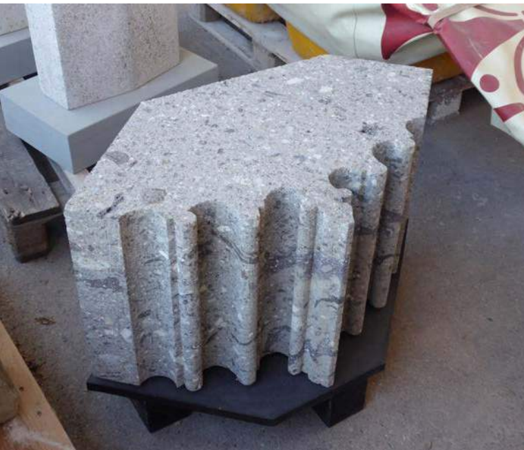
Abbildung 8: Profiliertes Stück aus Seelbronner Suevit aus der Werkstatt Matthias Wittner für den Einbau in der St. Georgskirche in Nördlingen (Foto: Klaus Poschlod).
