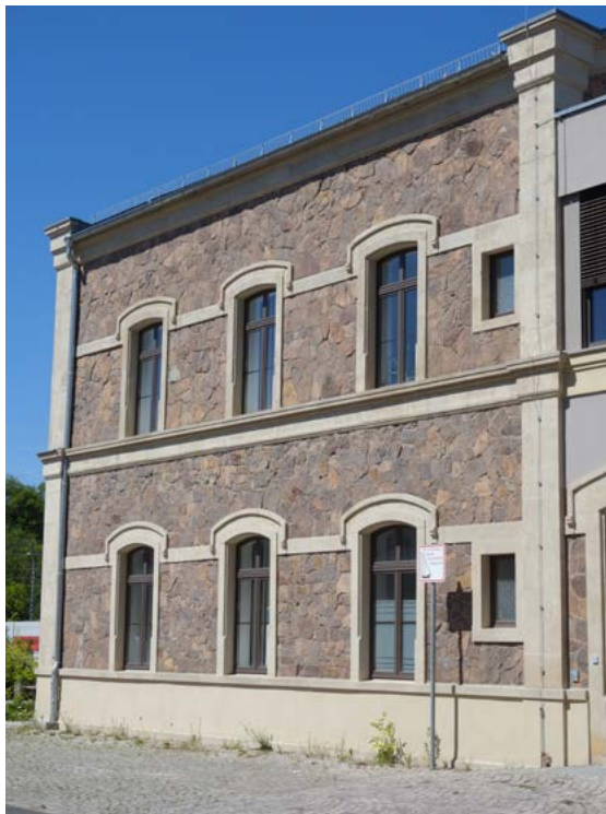
Abbildung 10: Seitenflügel des Bahnhofsgebäudes von 1855 in Freital-Potschappel, an dem „Porphyr“ in unregelmäßigem Sichtmauerwerk im Verbund mit Fenstergewänden und Gliederungselementen aus Elbsandstein verbaut wurde.
