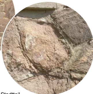
Abbildung 16: Christuskirche im Stadtteil Deuben. Mit Detailansicht der Natursteinverwendung im Sockelbereich der Kirchen. Teilweise sind leichte oberflächliche Verwitterungsstrukturen erkennbar (Foto: Dittrich/UVMB 2020).
