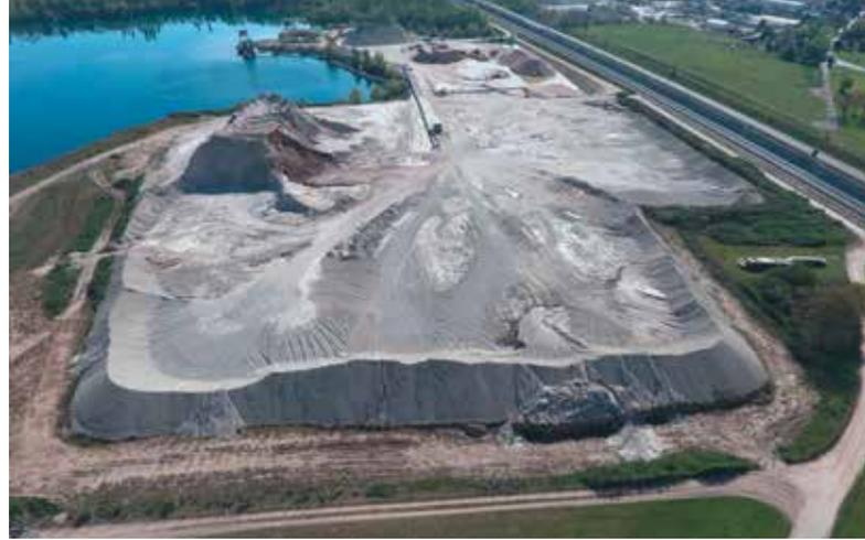
**Lagerfläche für das Tunnelausbruchmaterial: Durch eine gezielte Aufbereitung konnten rund 700.000 m<sup>3</sup> Deponievolumen eingespart werden.**
