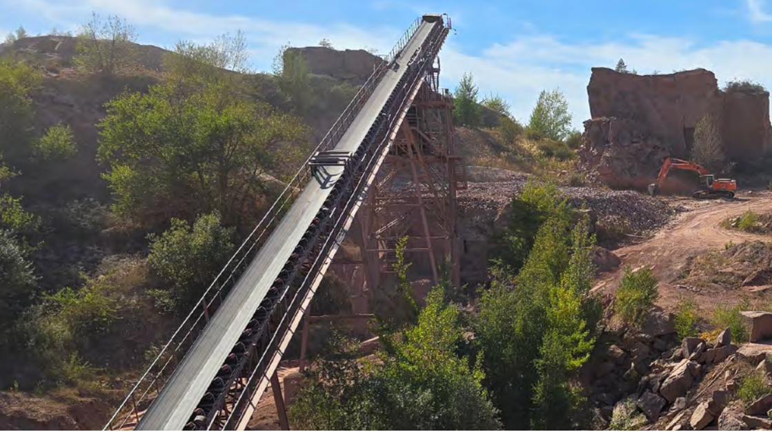
Abb. 2: Blick auf die Aufbereitungsanlage (Foto: R. Devrient).
