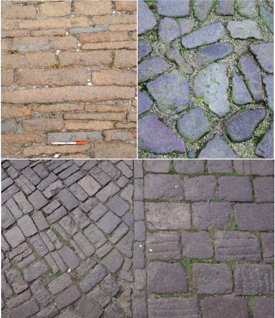
Abb. 7: Pflaster aus lokalem Rhyolith aus der Erbauungszeit um 1740 am Schloss Hubertusburg in Wermisdorf (Sachsen) (Fotos: H. Siedel)
