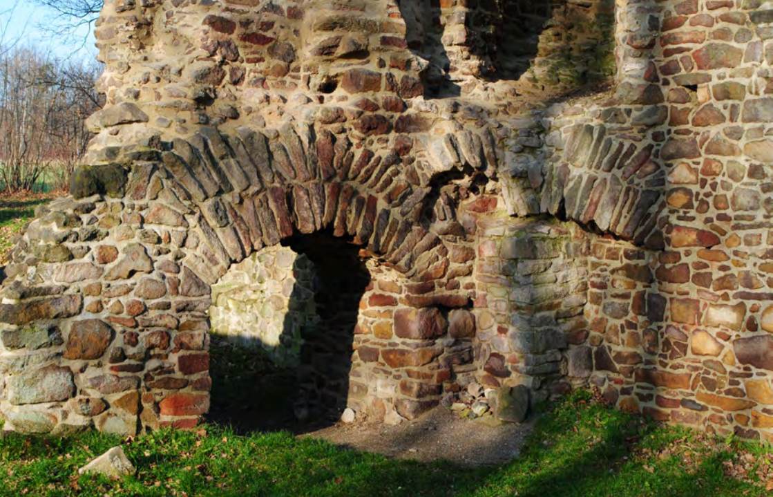
Abb. 2: Teilansicht der romanischen Ruine des Schlosses Osterland bei Oschatz (Sachsen) mit Bruchsteinmauerwerk aus lokalem Rhyolith (Foto: H. Siedel).
