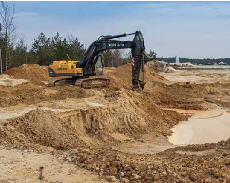
Bagger beim Anlegen des „Großen Kleingewässers“
