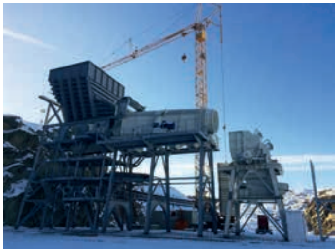
Mit dem Bau der neuen Vorbruchanlage mit Siebtrommel wird eine nahezu vollständige Ausnutzung der Lagerstätte ermöglicht.
