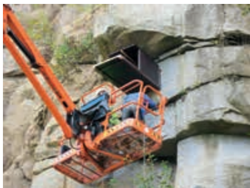
Bau eines Nistkastens als unterstützende Maßnahme.
