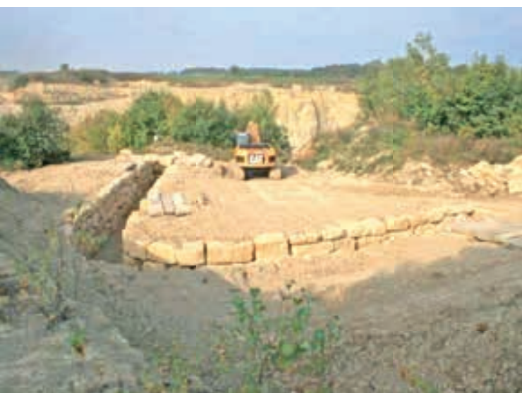
So entsteht der Fledermausstollen.
