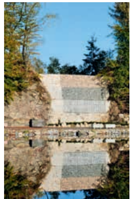
Dreifarbige Gabionenwand in imposanter Kulisse.
